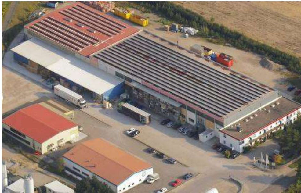
VARIOTEC Produktion / D-Neumarkt mit 110 kW PV-Anlage
