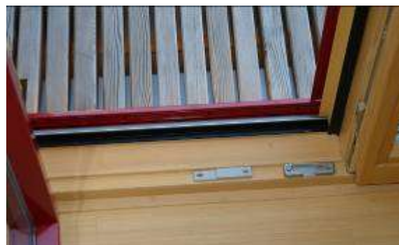
Passivhauszertifiziertes Energyframe Holz:Alu-Fenster U_w < 0,72 \text{ W}/(\text{m}^2\text{K})
