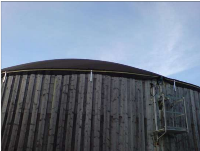
Gebäudehülle einer Biogasanlage
