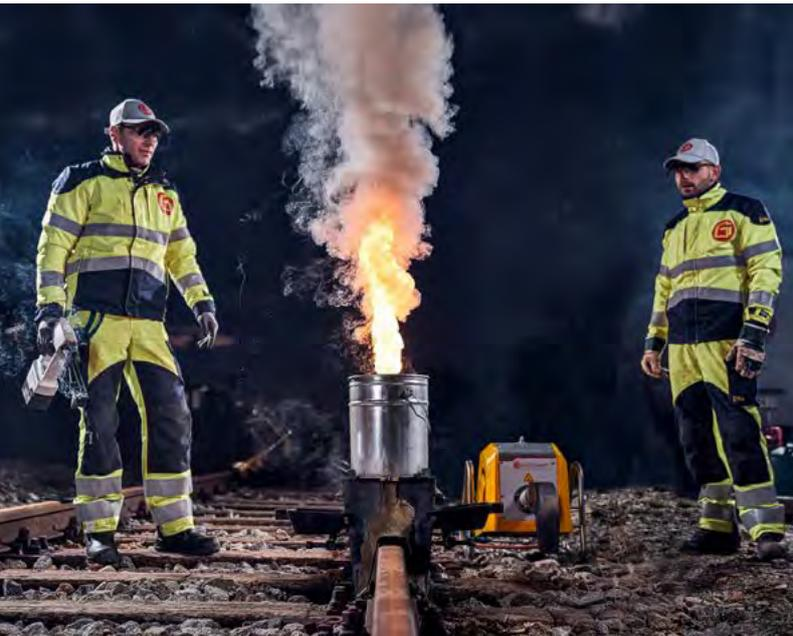
Lückenloses Verschweißen von Bahngleisen mit Thermit®.
