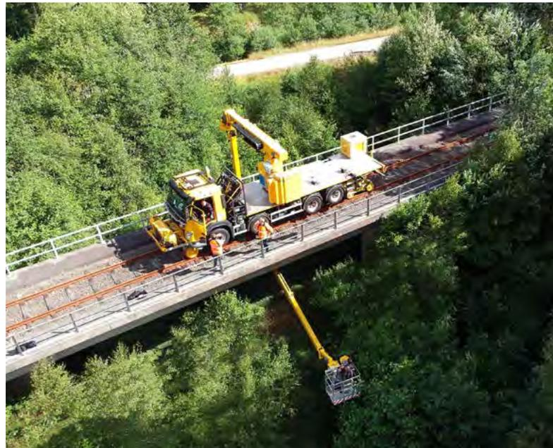
Inspektion einer Eisenbahnbrücke mit einem Zweivegfahrzeug.
