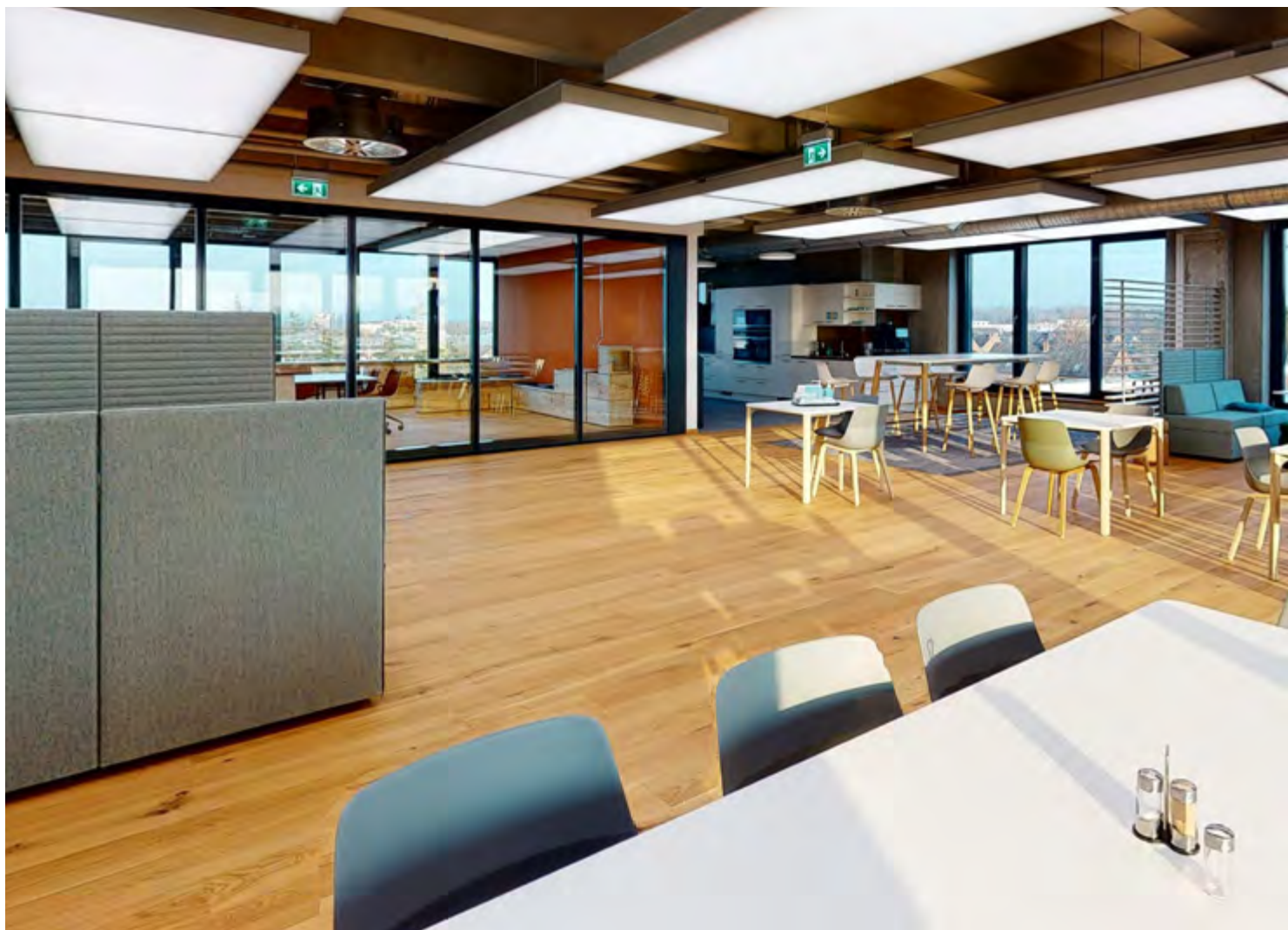
Ausgefeiltes System: Deckensegel, die tageslichtnahe Arbeitsplatz-Beleuchtung, hochabsorbierende Akustik, effiziente Heizung und wartungsfreie Kühlung bilden eine Einheit.
