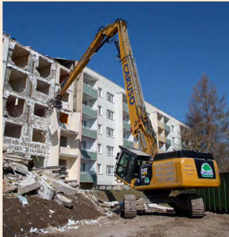
Abbruch von Plattenbauten mittels Longfrontbagger.
